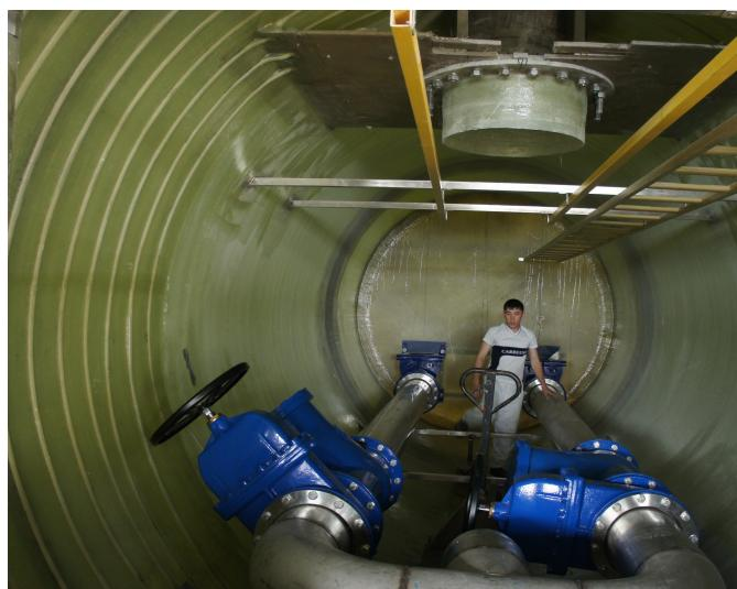
Корпус канализационной насосной станции представляет собой цилиндрическую емкость, изготовленную из прочного армированного стеклопластика согласно техническим требованиям Заказчика.
